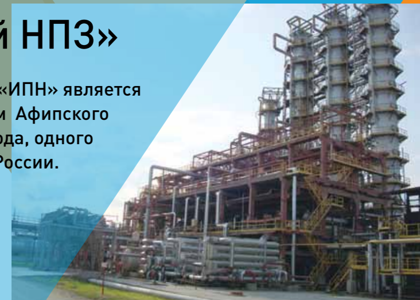
▲ Реконструкция установки атмосферной перегонки 22/4. 2012-2013 г.
