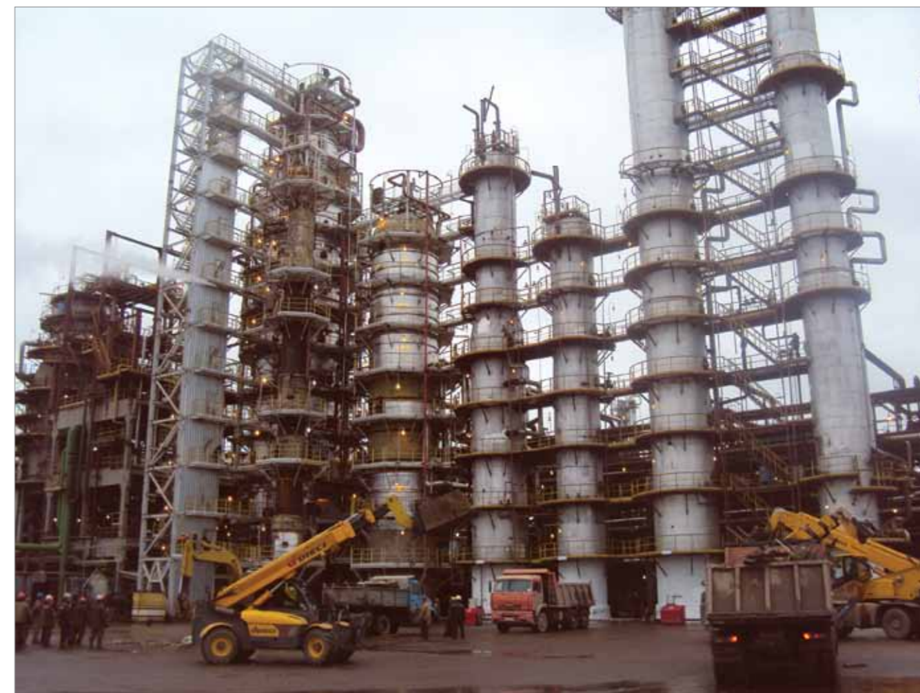
Реконструкция установки ЭЛОУ-АВТ-6 с заменой ректификационных колонн. 2012-2013 гг.
