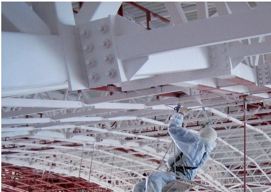
Рисунок 1 – Нанесение тонкослойного материала ОГРАКС-СК-1 на металлоконструкции
