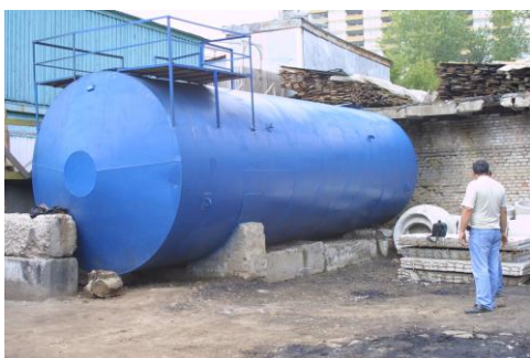
Фото 5. Резервуар объемом 70 м 3
