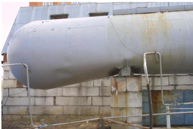
Фото 1. Деформация корпуса газгольдера объемом 175 м 3 в зоне опоры (2006 г.)
