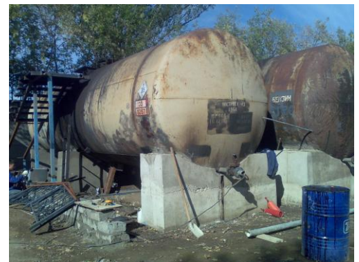
Фото 13. Резервуар объемом 175 м 3
