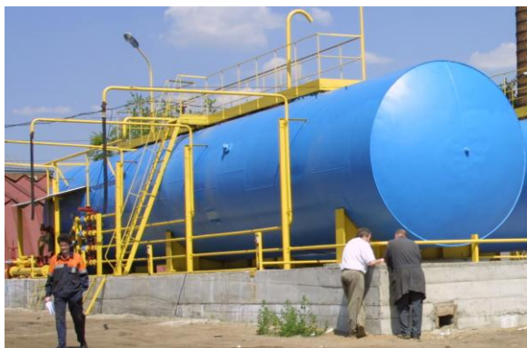
Фото 3. Резервуар объемом 200 м 3
