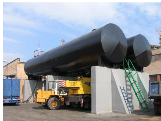
Фото 4. Резервуары объемом 200 м 3
