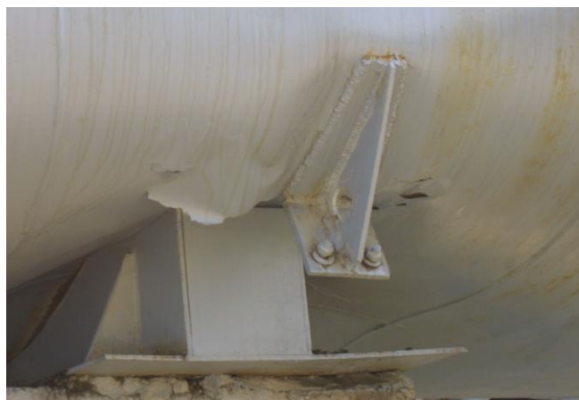
Фото 1. Деформация корпуса газгольдера объемом 175 м 3 в зоне опоры (2006 г.)
