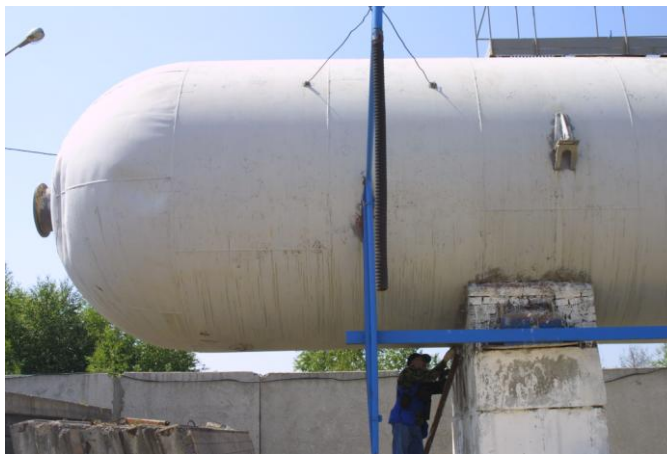
Фото 16. Резервуар объемом 180 м 3
